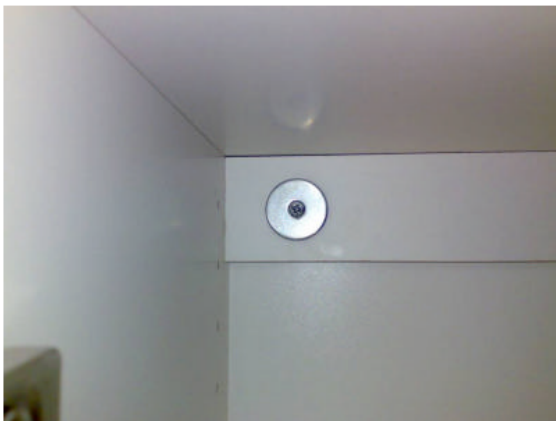
Figur 23. Täckbricka över Sylomerbricka. Bulten hindras från att komma emot skåpsstommen med genomgående Sylomerhylsa och en plasthylsa, som medger normalt åtdragningsmoment. Lösningen kändes robust att montera.
