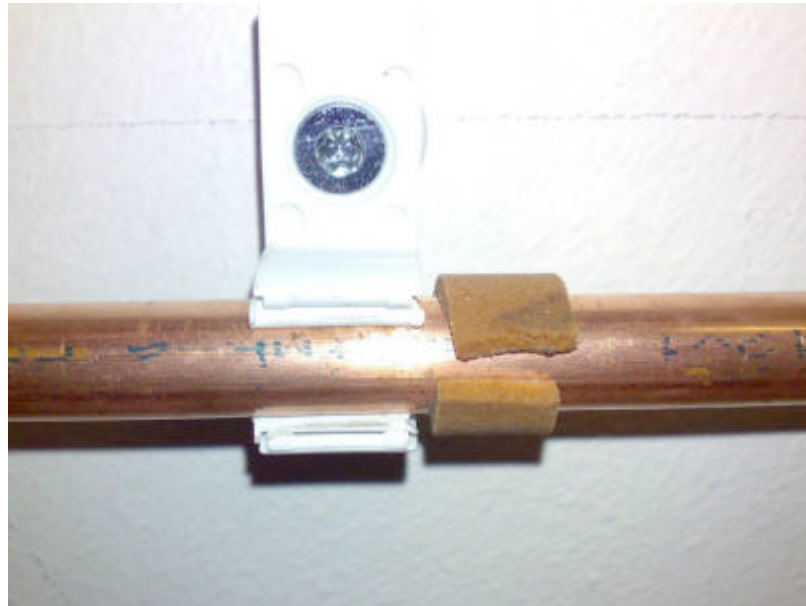
Figur 13. Normal montering av KV/VV-rör 12 mm, med distans för 15 mm väggfäste.
