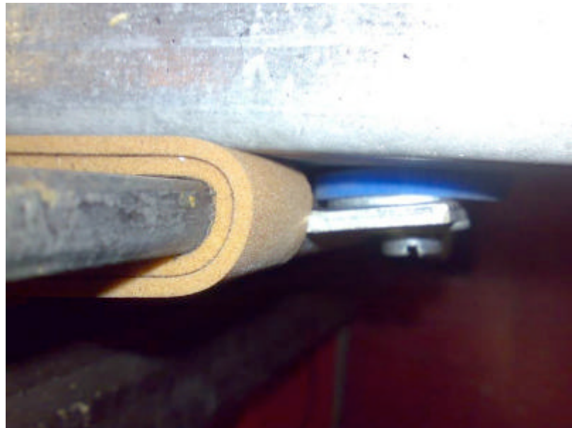
Figur 19. Brickor och självhäftande band av Sylomer (Christian Berner) monterades mellan gejdern och beslaget. Flänsen på beslaget pressas stumt mot gejdern (Sylomerduken sitter ovanför och under beslaget). Beslagets rörlighet beror helt av att den genomgående bulten kan röra sig. Mellan bult och balk sattes en Sylomerhylsa för att säkerställa en elastisk funktion. Sylomerhylsan skadades dock av de vassa stålkanterna i hålen. Hade man använt genomgående stålhylsor hade dessa säkerställt att bulten löpt fritt och att Sylomerhylsan inte skadats.
