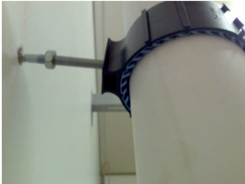
Figur 9. Ljuddämpande svep till plaströr Poloclip HS, med elastiska lameller.
