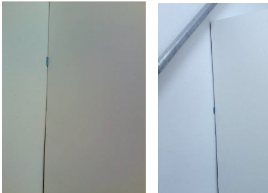
Figur 25. Med endast en Sylomerbricka (4 mm) på baksidan kom skåpets baksida (en i överkant och en i underkant, på respektive sida av skåpet) att vila mot en ojämnhet i väggen. Med två brickor säkerställdes att skåpet inte låg an emot väggen
