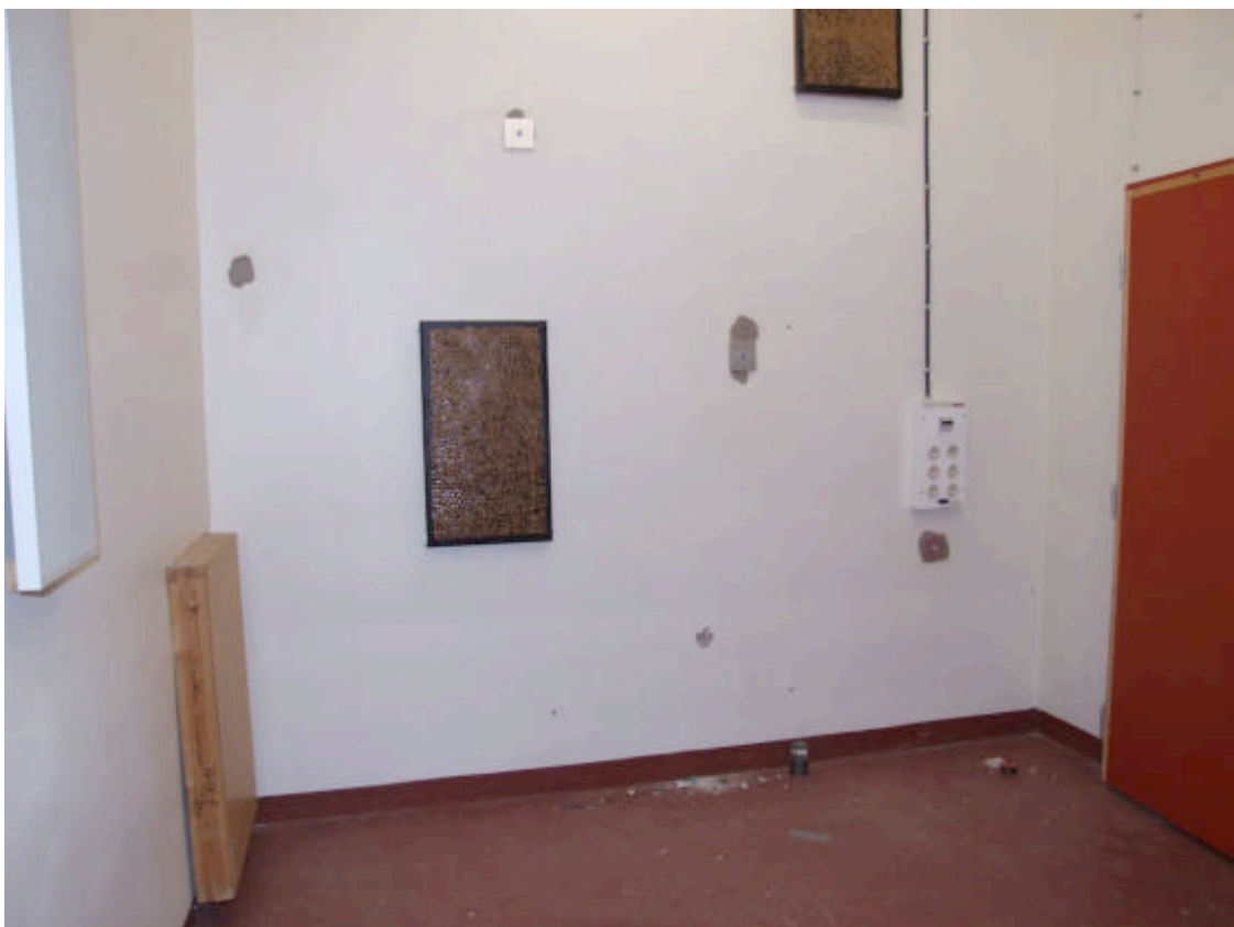
Figur 2 Installationsväggen sett från mätrummet.
