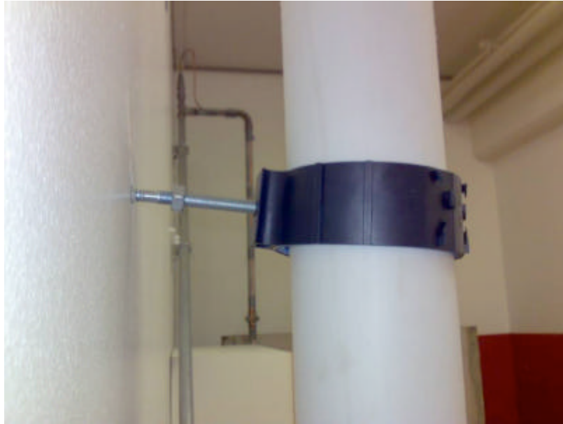
Figur 10. Vid snett infäst stift vrids det ljuddämpande svepet och får sämre elasticitet mot röret.
